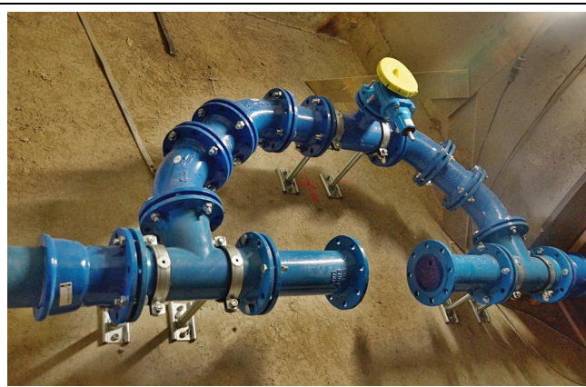
Obr. 20 Technické řešení umožňující montáž topných kabelů do potrubí s možností výměny
