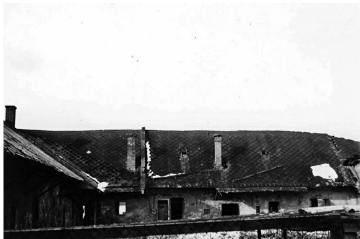
Pohled na hospodářskou část čp. 20 před demolicí
